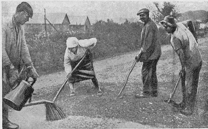
Ремонт дороги в Сухумском районе с помощью трудучастия населения.
